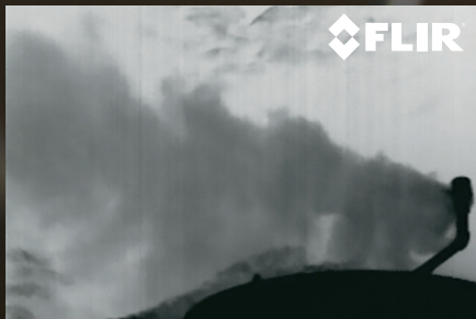
ENTLÜFTUNGSÜBERDRUCKVENTIL AN EINEM LAGERTANK
