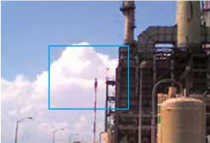
Obwohl die Flamme für das menschliche Auge unsichtbar ist, kann eine Wärmebildkamera überwachen, ob eine Fackel brennt.
