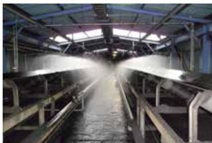
Die SPS stoppt das Förderband sofort und aktiviert die Sprinkleranlage bei Auslösung des Temperaturalarms.
